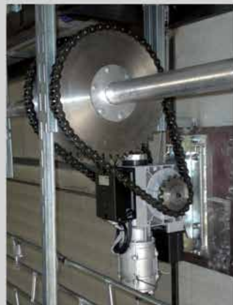
Particolare motore con rinvio a catena
