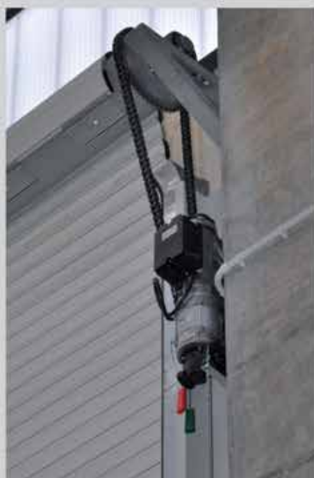
Motore laterale con rinvio a catena
